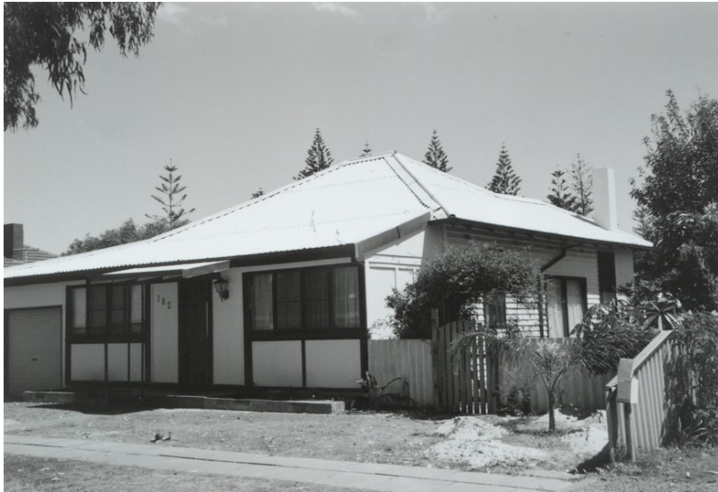
Photo Description: 24/10/1996 Suba & Grundy Verandahs fully enclosed.
